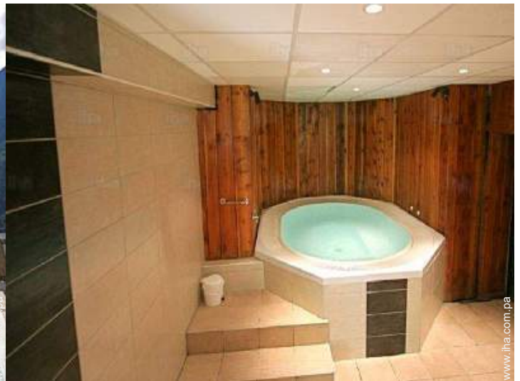
Instalaciones a disposición
