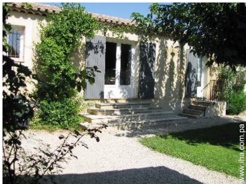
vista desde la terraza cubierta
